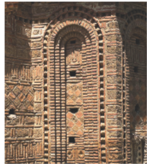
"Aziz Meryem Perivlepta" Kilisesinin Cephe Detayları
