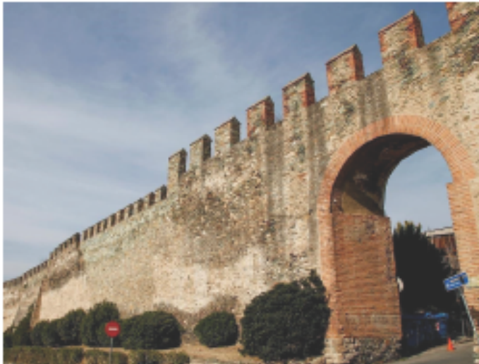
Selanik'teki şehir surlarının günümüze kalan bölümleri
