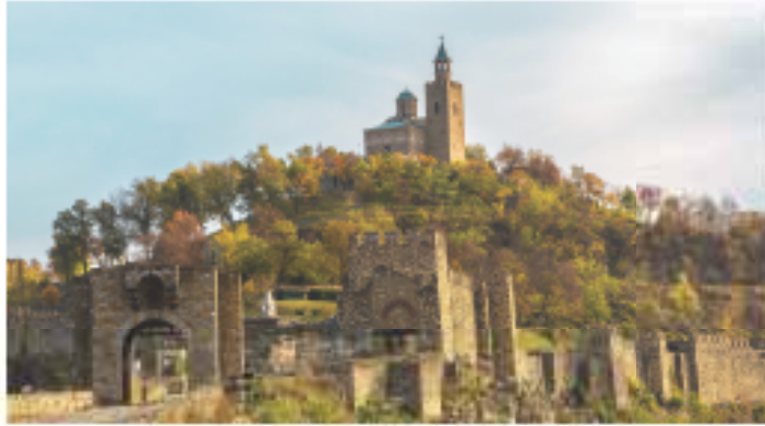
Tırnova Kalesi Çarevets'teki Kilise ve Surlar
